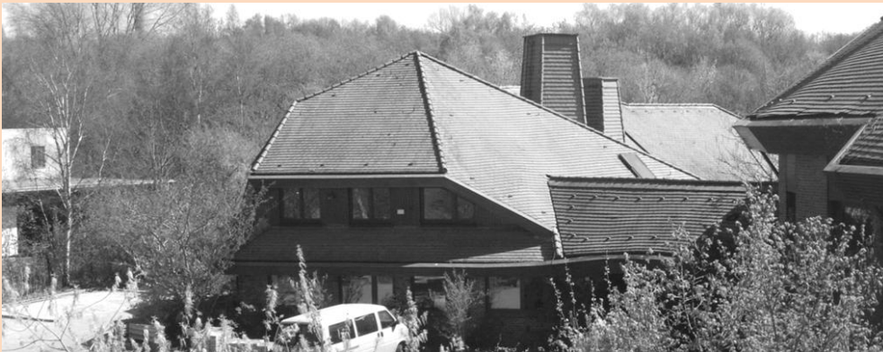
Eingangsbereich mit Büroobergeschoss
