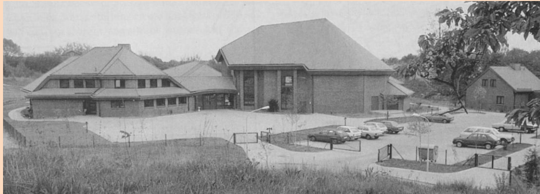
Gesamtansicht von Northwest, rechts Hausmeisterhaus
